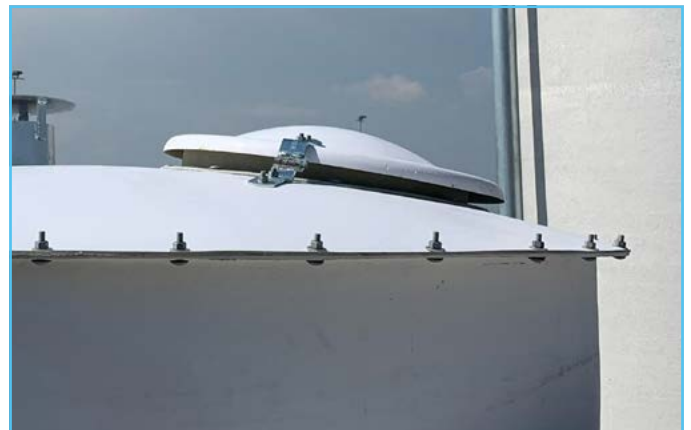
4 Coperchio con cerniera e galletto Lid with hinge and wing nut
